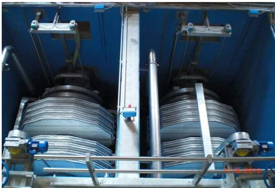
7.8 Stabilizzazione aerobica dei fanghi: n. 1 comparto di Volume utile mc 520.
