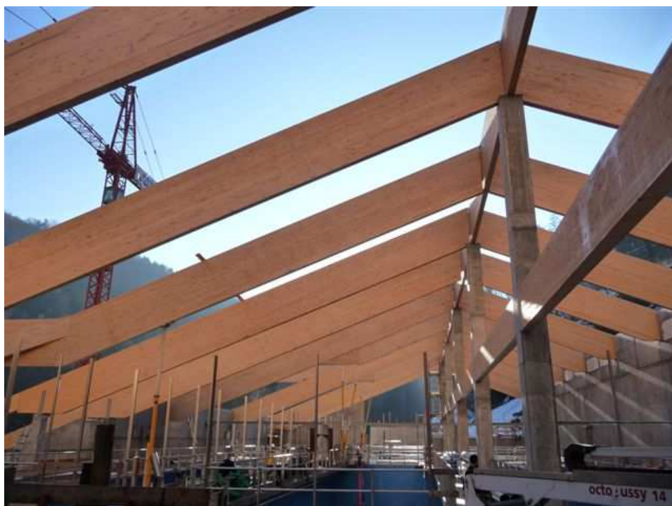
Foto 2: installazione travi del tetto in legno lamellare
