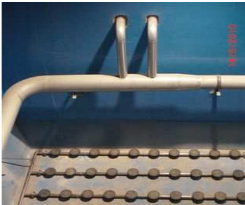
7.8 Stabilizzazione aerobica dei fanghi: n. 1 comparto di Volume utile mc 520.
